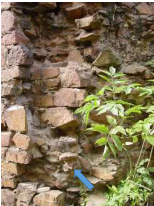
Abb. 8 Anfang des 13. Jh. verblendetes Kernmauerwerk an der Nordseite des Gebrauchskirchenraumes auf mitverblendeter Altgründung (Pfeil)
