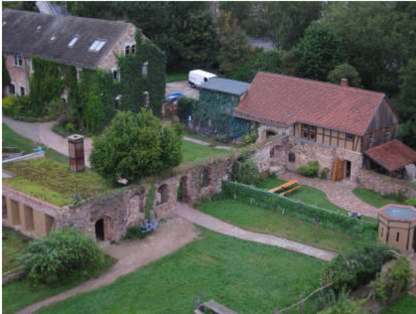
Abb. 26 Blick auf neue Strukturen unter Einbindung der historischen Bausubstanz, westlicher Teil der Klosterkernzone
