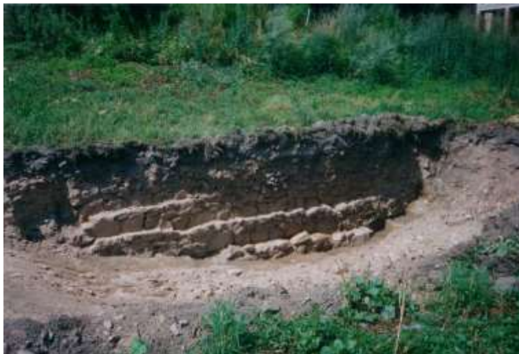
Abb. 5 Bei einer ungenehmigten Grabung am westlichen Hangfuß freigelegte, mehrstufige Gründung, 1992/93
